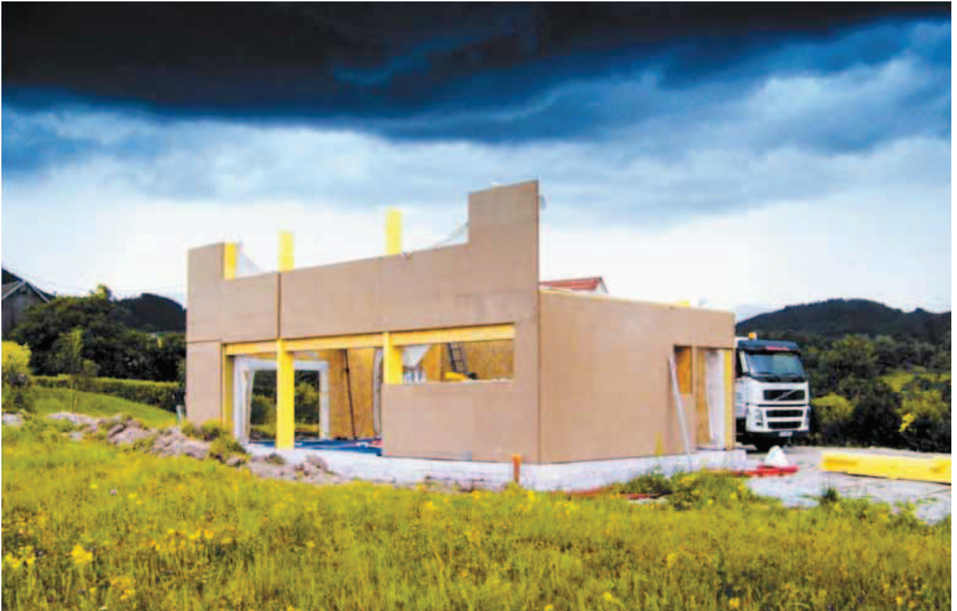
Les panneaux sont assemblés sur site. L'étanchéité à l'air est soignée.
