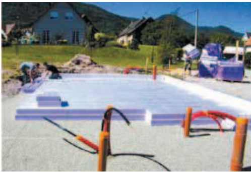
Pose du Jackodur Atlas, système isolant de la dalle.
