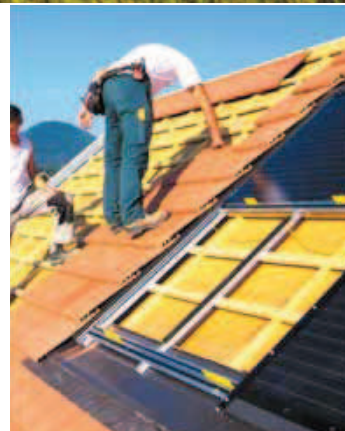
Pose des panneaux photovoltaïques en toiture.
