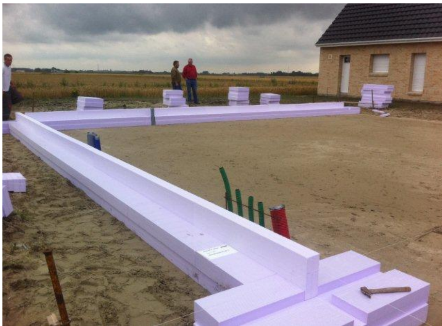
Visuel 0115 : Isolation des murs extérieurs avec l'isolant Jackodur Atlas d'une épaisseur de 24 cm.
