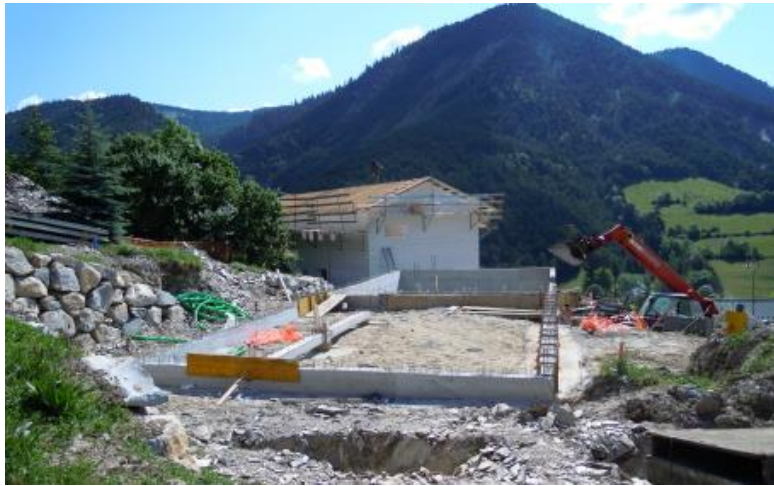
30 juillet : toiture et vitrages en place pour le bâtiment est
