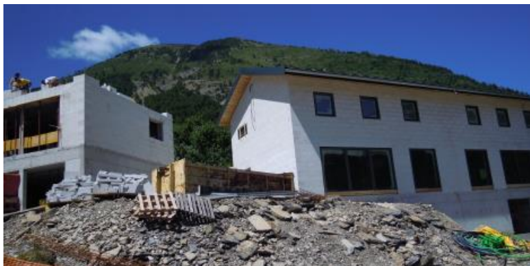
28 août : cloisons en place dans le bâtiment est
