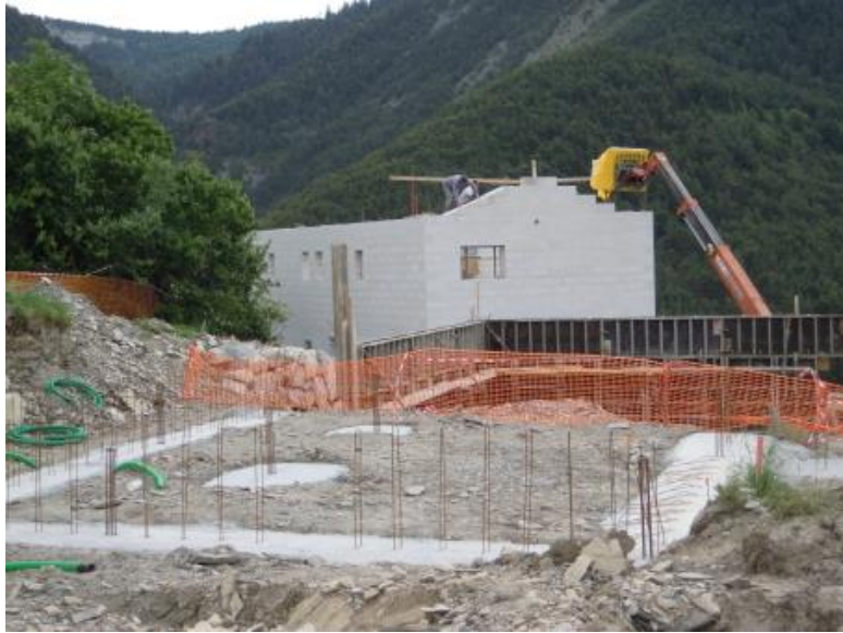
5 juillet : pose du toit du bâtiment est
