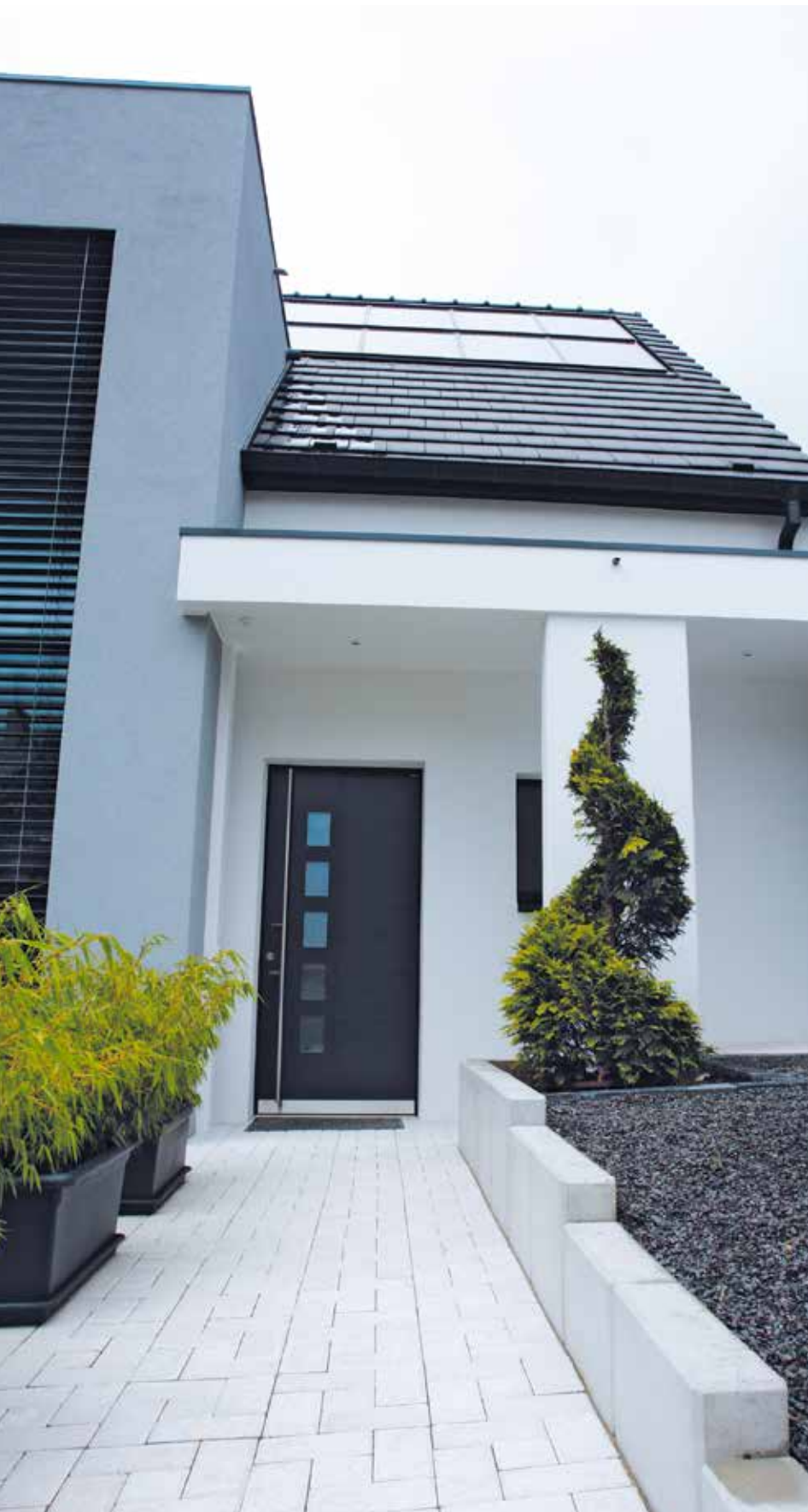
La toiture intègre 32 m 2 de panneaux photovoltaïques.
