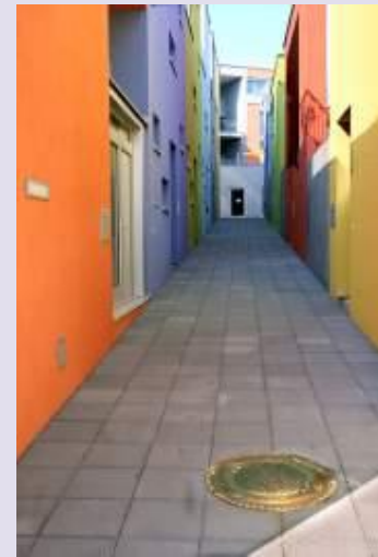
Maisons passives jumelées
