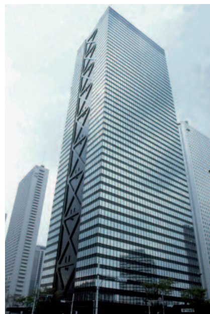
Fig. 26 - Pignons rigidifiés par des éléments de contreventement
