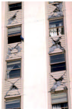
Fig. 87 - A proscrire : discontinuité des ouvertures sur la hauteur de l'immeuble. L'étage sans ouvertures constitue un point dur voué à éclater en cas de séisme fort.
