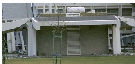
Fig. 15 - Rupture de porte-à-faux, séisme de San Fernando, Californie 1971
