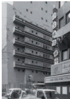
Fig. 49 - Dommages aux voiles en béton facilement réparables, occasionnés par le séisme de Kobé, Japon 1995 (6 300 morts). L'immeuble est situé dans la zone la plus touchée par le tremblement de terre
