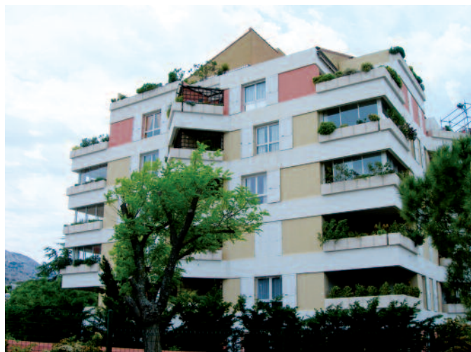
Fig. 78 - Bâtiments d'habitation à ossature en portiques de béton armé et façades non structurales en maçonnerie : la rigidité cumulée des panneaux de façade devrait être sensiblement symétrique dans chaque direction principale
