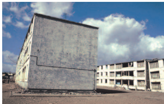
Fig. 83 - A éviter: absence de voiles périphériques en vide sanitaire. Cette construction est particulièrement vulnérable aux séismes
