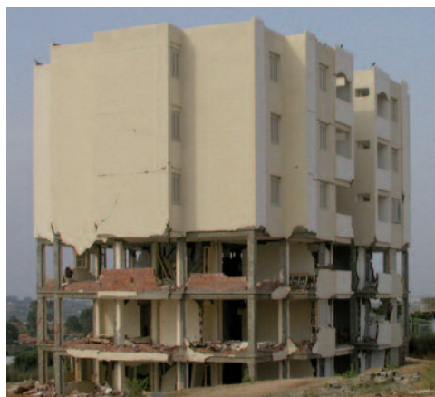
Fig. 50 - Éclatement de panneaux de remplissage en maçonnerie lors du séisme de Boumerdès, Algérie 2008
