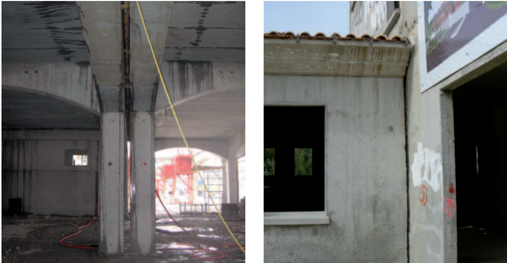
Fig. 25 - Exemple de joints sismiques vides de tout matériaux
