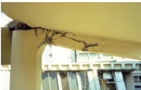
Fig. 43 - Rupture de porte-à-faux, séisme de San Fernando, États-Unis 1971
