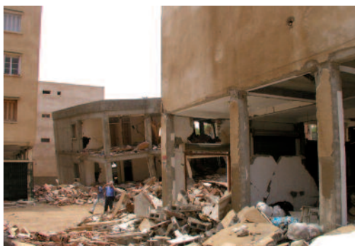
Fig. 51 - L'éclatement de remplissages transforme les rez-de-chaussée en niveaux souples, dont l'écrasement est fréquent, séisme de Boumerdès, Algérie 2008
