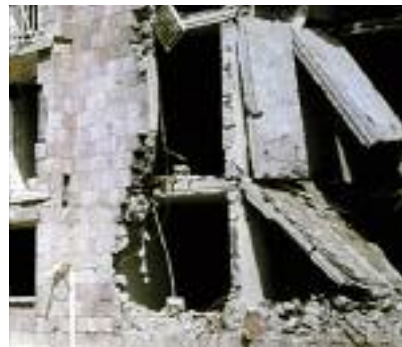
Fig. 106 - Effondrement de planchers lors de secousses sismiques séisme de Spitak, Arménie 1988
