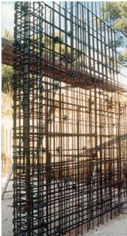
Fig. 101 - Exemple de l'armature d'un mur ductile
