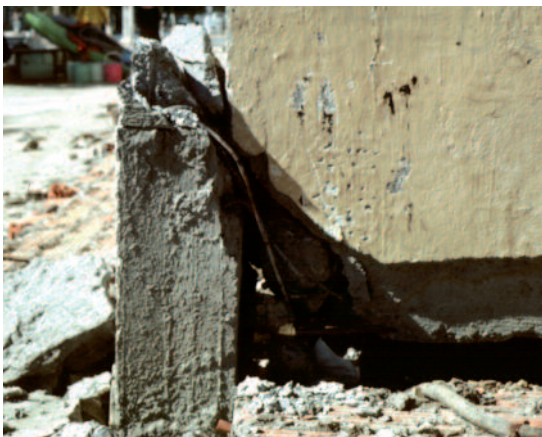
Fig. 36 - Dommages dus à l'effet de poteau court en vide sanitaire, séisme d'El Asnam, Algérie 1980
