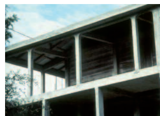
Fig. 79 - A éviter : portiques à poteaux discontinus
