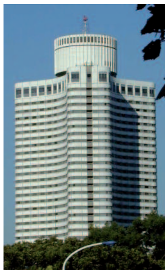
Fig. 28 - Variation progressive de la rigidité des voiles supportant les étages en retrait
