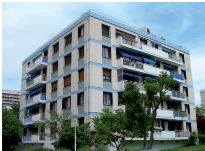
Fig. 78 - Bâtiments d'habitation à ossature en portiques de béton armé et façades non structurales en maçonnerie : la rigidité cumulée des panneaux de façade devrait être sensiblement symétrique dans chaque direction principale
