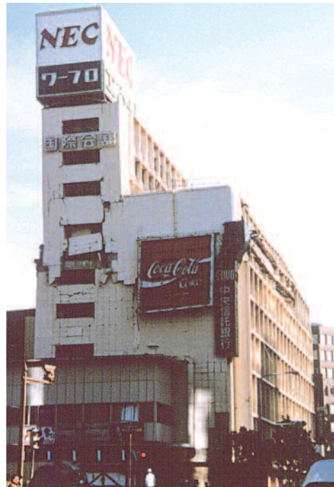
Fig. 21 - Dommages dus à des oscillations différentielles en plan et en élévation, séisme de Kobé, Japon 1995
