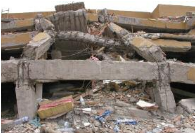
Fig. 88 - Effondrement des ossatures en portiques de béton armé non confiné, de Boumerdès, Algérie 2003 et séismes d'Izmit, Turquie 1999
