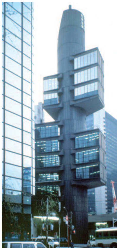
Fig. 44 - Grands porte-à-faux : architecture déconseillée en zone sismique (rampe hélicoïdale à Osaka et immeuble à Tokyo, Japon)
