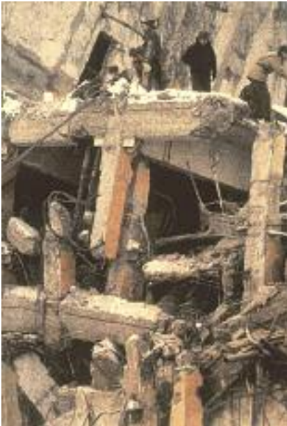
Fig. 89 - Comparaison d'un comportement fragile (rupture instantanée) d'une ossature non confinée et du comportement ductile (plastique) d'une ossature confinée. L'effondrement de cette dernière construction est dû à un choix d'architecture défavorable et non à une erreur d'exécution : effet de poteau court à l'intérieur du bâtiment (séismes de Spitak, Arménie 1988 et de Northridge, Californie 1994)
