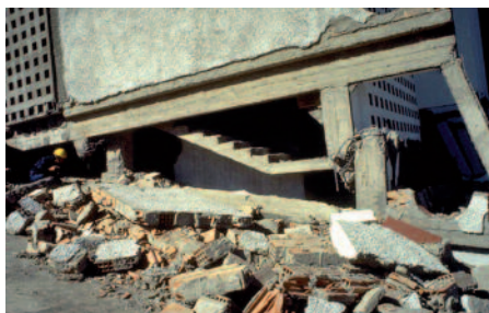
Fig. 39 - L'effet de poteau court dû à la présence d'un palier d'escalier, séisme d'El Asnam, Algérie 1980
