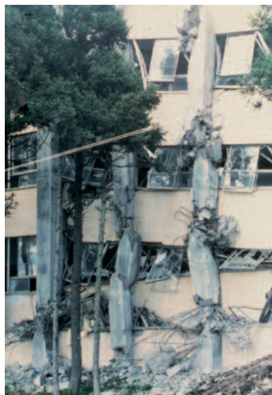
Fig. 74 - Effondrements de bâtiment dû au non-respect du principe « poteaux forts - poutres faibles ». La résistance ultime des poutres-allèges en béton armé était supérieure à celle des poteaux. En outre, on peut observer l'effet de poteau court (séisme de Tokachi-Oki, Japon 1968 et d'Izmit, Turquie 1999)
