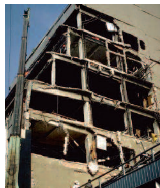
Fig. 80 - Dommages sismiques dus à des retraits d'étage, séisme du Mexique, 1985
