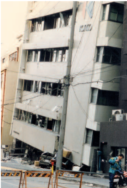
Fig. 32 - Dommages aux rez-de-chaussée « souples », séisme de Kobé, Japon 1995
