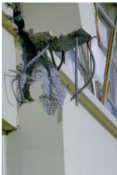
Fig. 75 - Poteaux et poutres dans des plans différents : rupture de nœud
