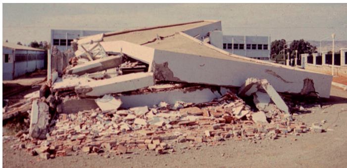
Fig. 17 - Effondrement dû à la torsion, El Asnam 1980
