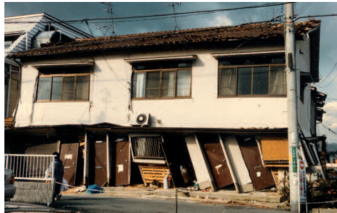
Fig. 32 - Dommages aux rez-de-chaussée « souples », séisme de Kobé, Japon 1995
