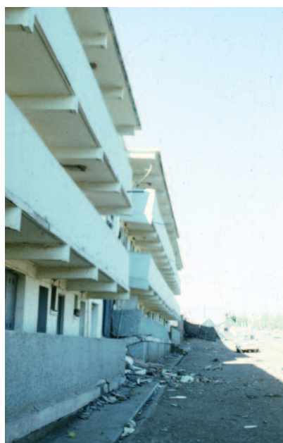
Fig. 45 - Dalles de balcon portées par des poutres en console. Ces poutres n'ont pas subi de dommages lors du séisme d'El Asnam, Algérie 1980. Les poteaux du vide sanitaire ont été cisailés par effet de poteau court
