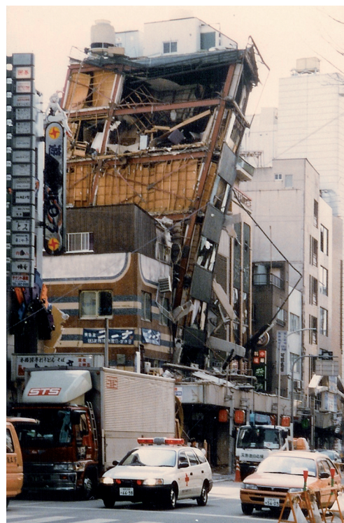
Fig. 13 - Dommages dus à la résonance du bâtiment avec le sol (Kobé, Japon 1995)
