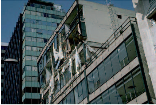
Fig. 68 - Dommages dus aux oscillations différentielles entre les étages en retrait et les niveaux inférieurs, séisme du Mexique, 1985
