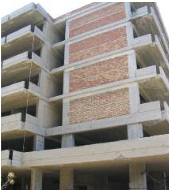
Fig. 97 - Raidisseurs en béton armé destinés à prévenir ou retarder l'éclatement des panneaux de remplissage en maçonnerie (à droite : après le séisme du Mexique, 1985)
