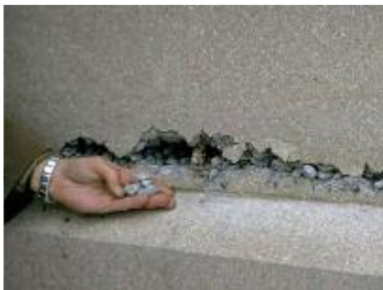
Fig. 102 - Dégradation du béton au droit d'un arrêt de coulage, séisme d'Alaska, 1964
