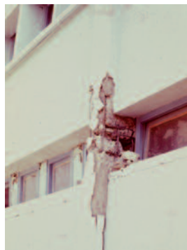
Fig. 37 - L'effet de poteau court dû à la présence d'allèges en maçonnerie dans la structure principale en portiques, séisme d'El Asnam, Algérie 1980
