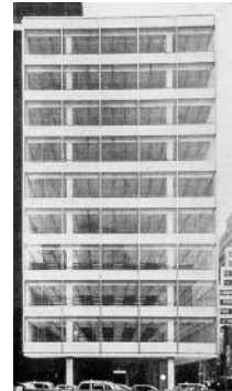
Fig. 35 - Structure de même rigidité horizontale à tous les niveaux
