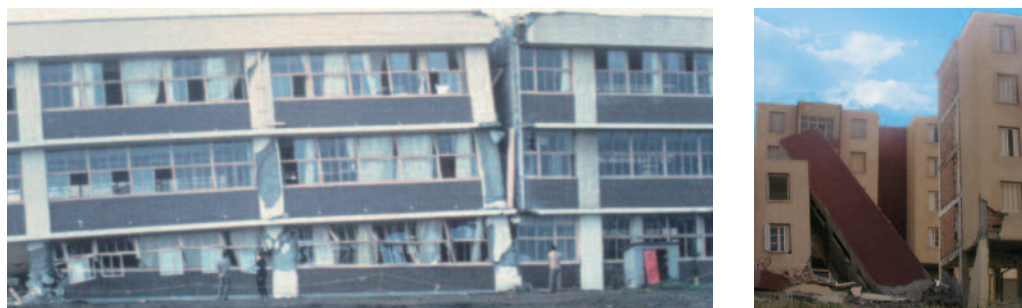
Fig. 23 - Dommages dus à l'entrechoquement de blocs contigus, séismes de Tokachi-Oki, Japon 1968 et de Boumerdès, Algérie 2003
