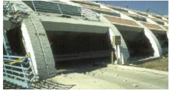
Fig. 89 - Comparaison d'un comportement fragile (rupture instantanée) d'une ossature non confinée et du comportement ductile (plastique) d'une ossature confinée. L'effondrement de cette dernière construction est dû à un choix d'architecture défavorable et non à une erreur d'exécution : effet de poteau court à l'intérieur du bâtiment (séismes de Spitak, Arménie 1988 et de Northridge, Californie 1994)
