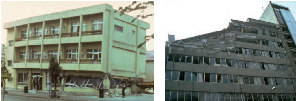
Fig. 59 - Dommages sismiques dus à la torsion d'ensemble, séismes de Tokachi-Oki, Japon 1968 et du Mexique, 1985
