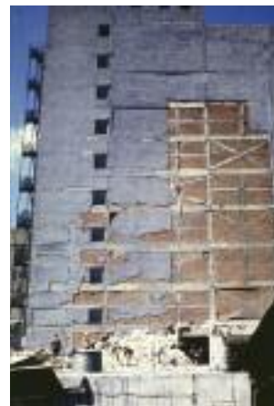
Fig. 97 - Raidisseurs en béton armé destinés à prévenir ou retarder l'éclatement des panneaux de remplissage en maçonnerie (à droite : après le séisme du Mexique, 1985)
