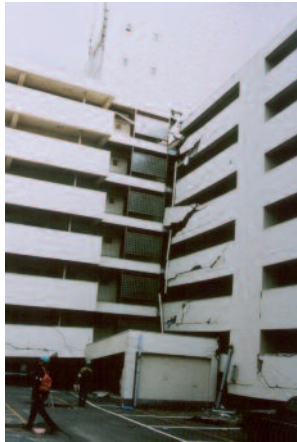
Fig. 21 - Dommages dus à des oscillations différentielles en plan et en élévation, séisme de Kobé, Japon 1995
