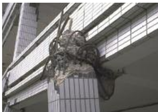
Fig. 91 - Éclatement de zones critiques: exemples de poutres, poteaux et nœuds de portique
