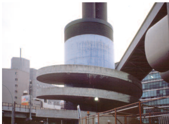
Fig. 44 - Grands porte-à-faux : architecture déconseillée en zone sismique (rampe hélicoïdale à Osaka et immeuble à Tokyo, Japon)
