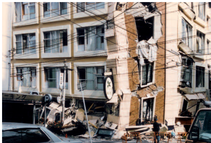
Fig. 19 - Effondrement d'un bâtiment d'habitation conforme aux règles parasismiques, séisme de Kobé, Japon 1995
