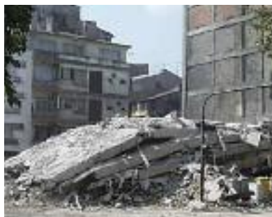
Fig. 88 - Effondrement des ossatures en portiques de béton armé non confiné, de Boumerdès, Algérie 2003 et séismes d'Izmit, Turquie 1999
