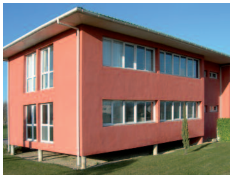
Fig. 83 - A éviter: absence de voiles périphériques en vide sanitaire. Cette construction est particulièrement vulnérable aux séismes
