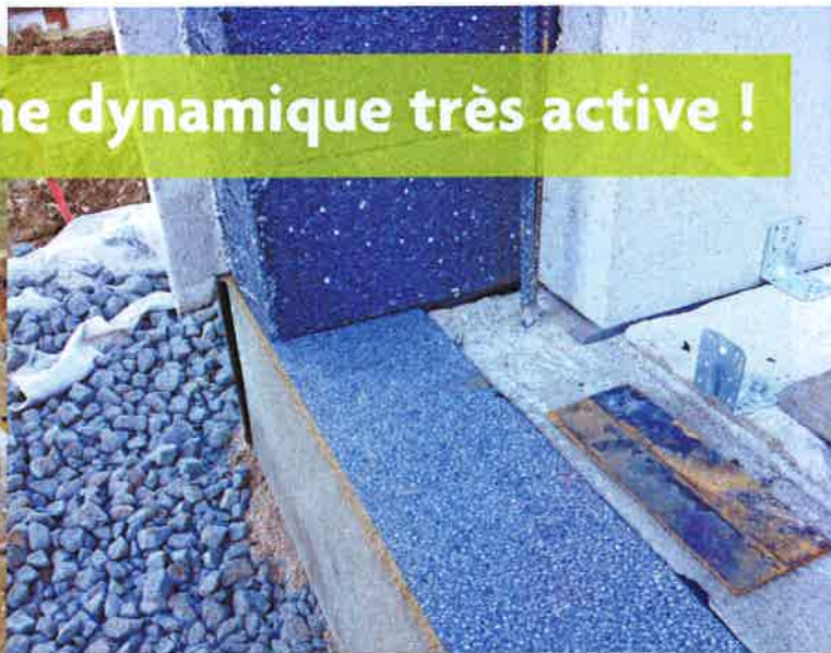
Quelques étapes d'un chantier de maison passive
