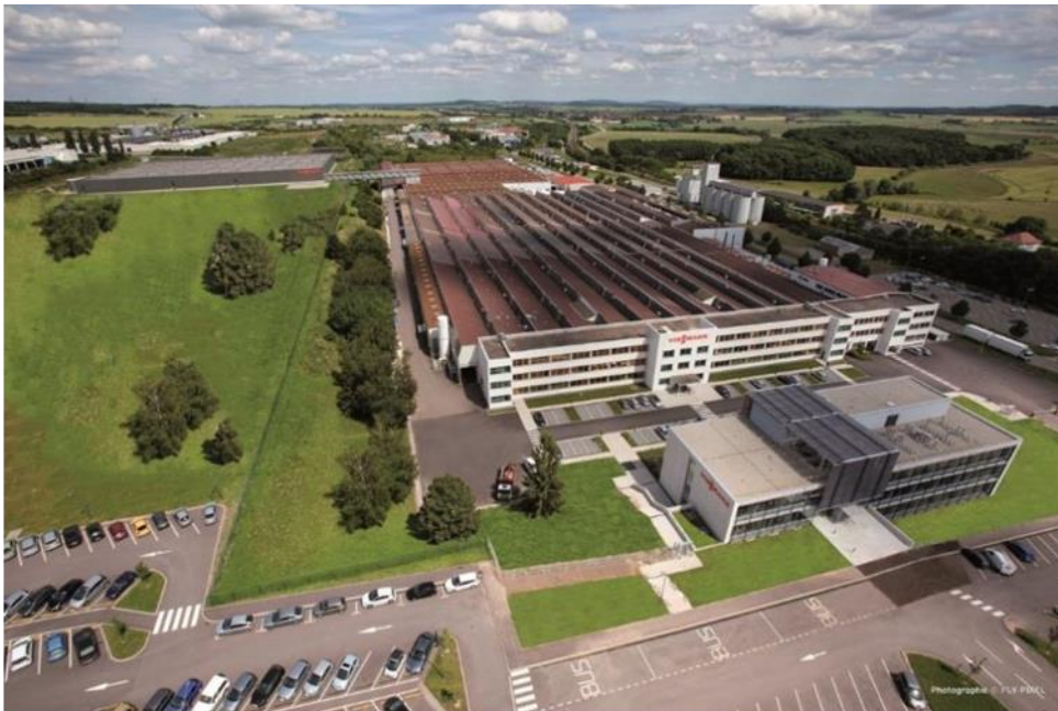
Site de Faulquemont : usine et siège commercial
