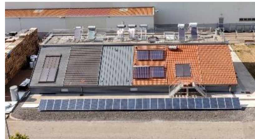
Centre d'essai de l'usine de Faulquemont
