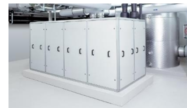
Pompe à chaleur de grosse puissance
