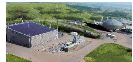
Installation de méthanisation, Allendorf/Eder (Allemagne)
